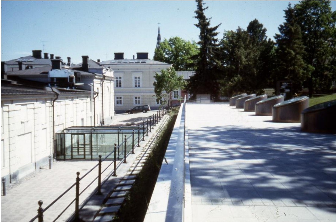
Laajennuksen katto toimii terassina Raatihuoneen puistossa. Kuva Gullichsen-Vormala Ky:n arkisto, ajankohta todennäköisesti juuri Siiven valmistumisen jälkeen vuonna 2000.
