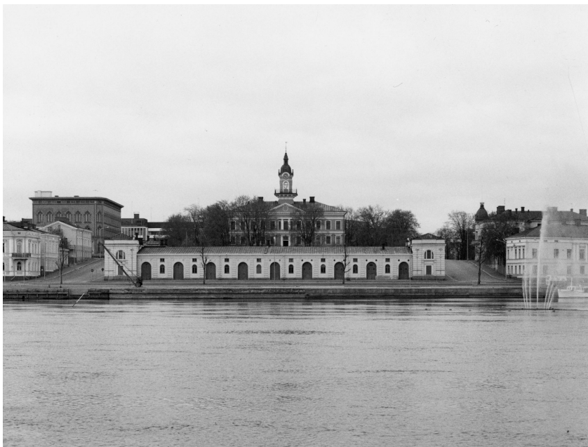
Kuva ajalta 1970–79, juuri ennen rakennuksen muuttamista taidemuseoksi. Satakunnan museon kuvakokoelma, kuvaaja Sven Raita.
