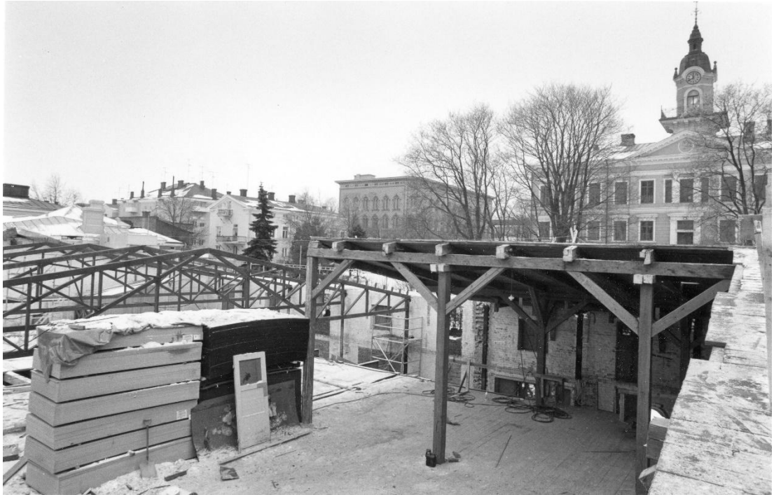
Vanhaa välipohjaa käytettiin ikään kuin rakennustelineenä. Kuva Satakunnan museo, kuvaaja Jalo Porkkala vuonna 1980.
