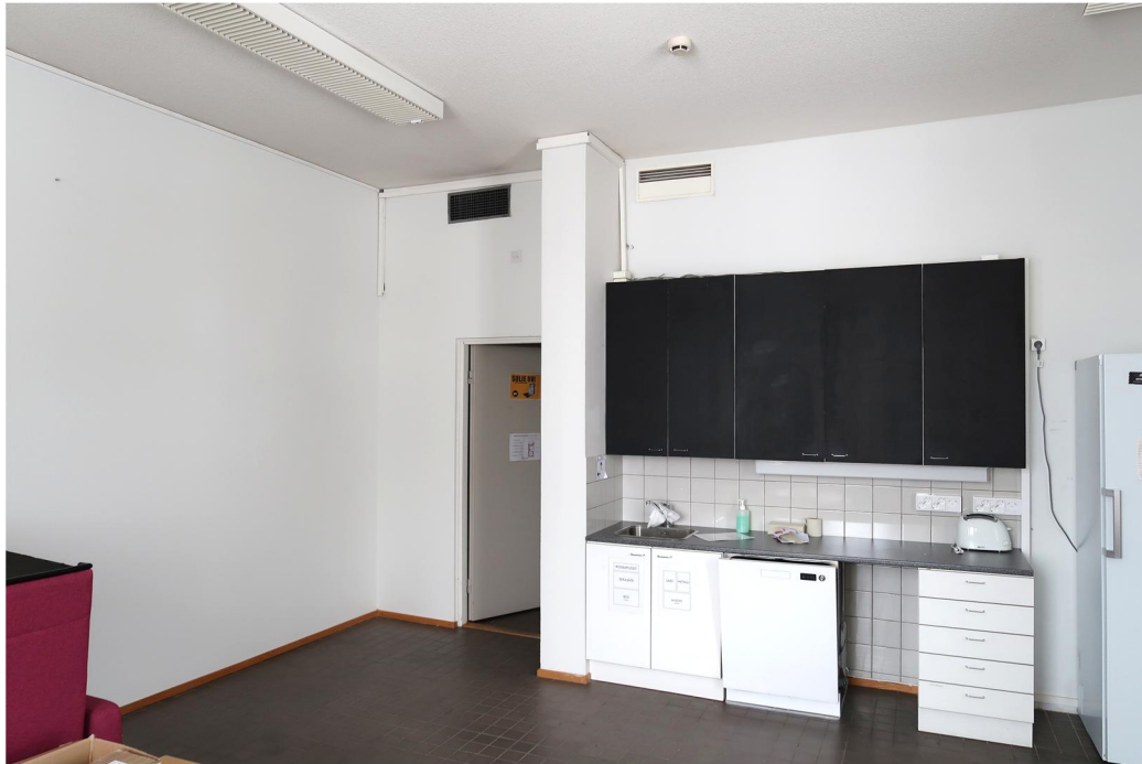
Länsipäädyn toisessa kerroksessa alkuperäiset ateljeetitilat ovat kulutusta kestäviä, lattioissa on tumma keraaminen laatta ja katot ovat vain tasoitettuja ja maalattuja.
