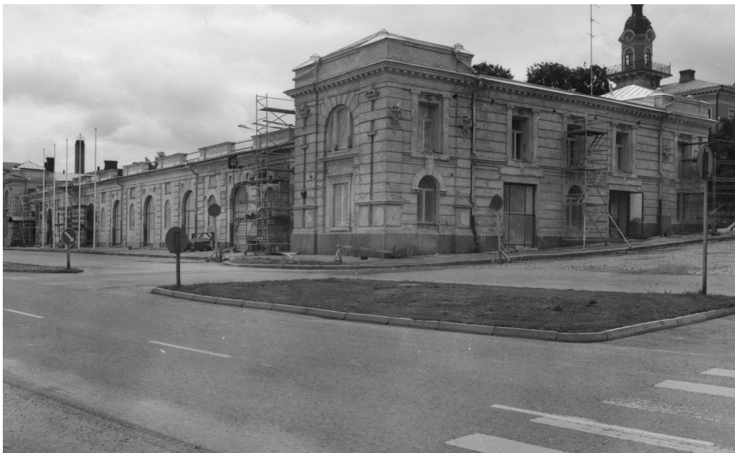
Tulli- ja pakkahuone vuonna 1981 kun taidemuseon tilat alkavat olla valmiit, mutta julkisivujen korjaus on edelleen kesken. Valokuvasta näkyy hyvin, miten rappaus korjattiin paikkaamalla, vanhat ikkuna- ja luokkuaukot jätettiin syvennyksinä julkisivuun ja matalan osan vesikatolle palautettiin sieltä 1950-luvulla poistettu kattokaide. Kuva Satakunnan museon kuvakokoelmat, kuvaaja Pentti Pere.
