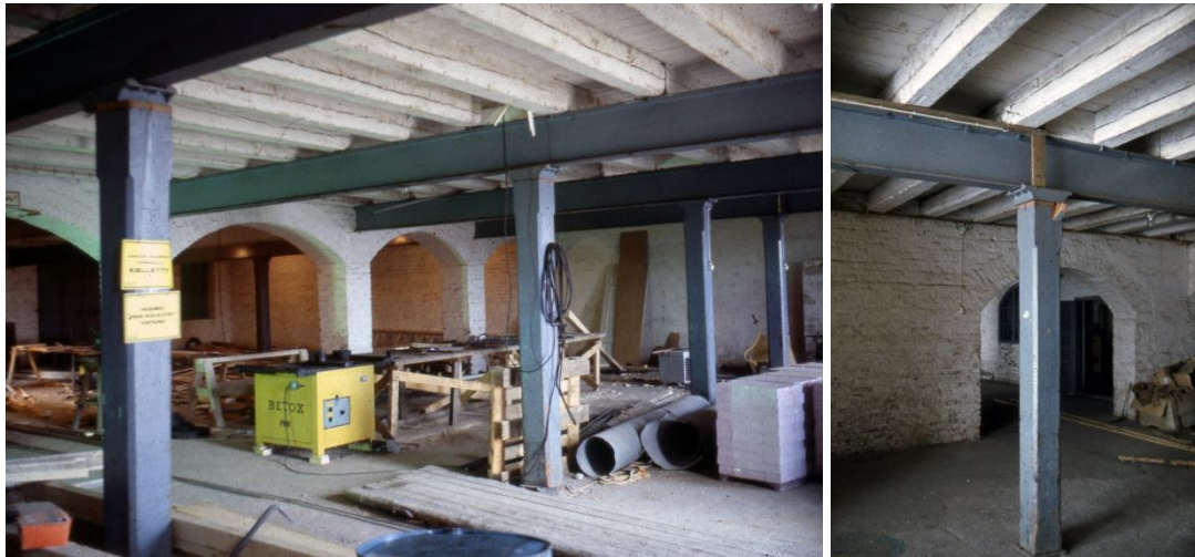
Kuvista näkyy, miten teräspalkkeja kantavat puupilarit oli veistetty nurkistaan ja muuratut seinät ja puisen välipohjan alapinta maalattu valkoisiksi -todennäköisesti lisäämään valoisuutta tiloissa. Kuva Gullichsen-Vormala Ky:n arkisto, ajankohta todennäköisesti 1960-70-luku.
