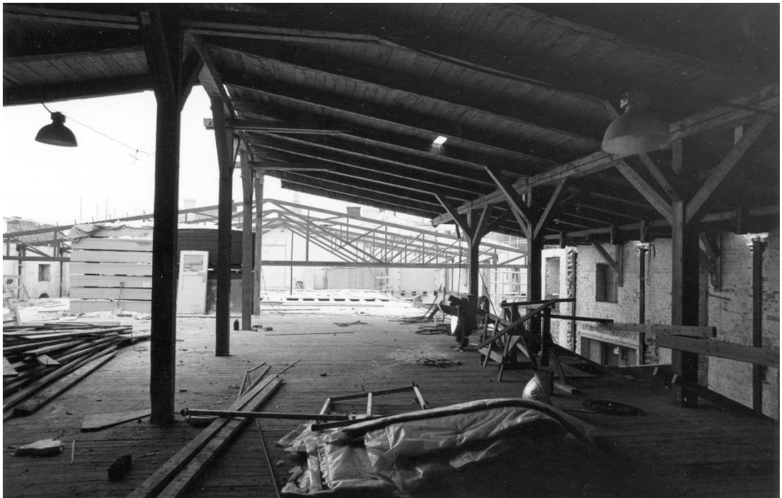
Uudet teräksiset kattoristikot nousevat sitä mukaa, kun vanhat puiset väistyvät. Kuva Satakunnan museo, kuvaaja Jalo Porkkala vuonna 1980.
