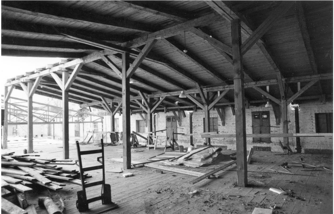
Tulli- ja pakkahuoneen vesikattoa kantoivat puupilarit ja -palkit. Yläpohja oli lämmöneristämätön. Kuva Satakunnan museo, kuvaaja Jalo Porkkala vuonna 1980.
